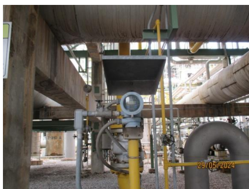
ภาพที่ 3-41 Flammable Gas Detector
