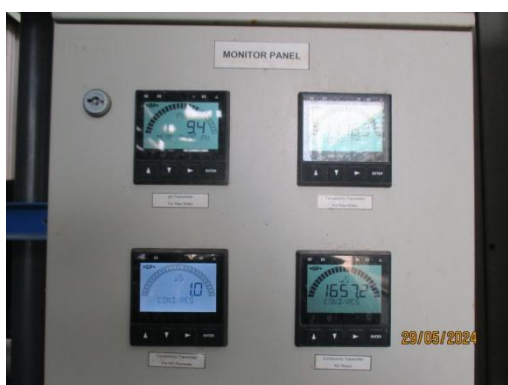
ภาพที่ 3-15 Conductivity Online บริเวณระบบ Reverse Osmosis
