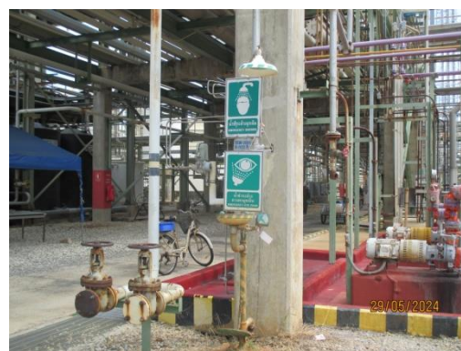
ภาพที่ 3-42 ฝักบัวฉุกเฉิน และที่ล้างตา
